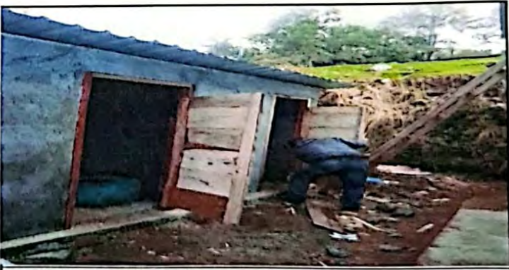
Foto 6: Reparacion de sanitario
