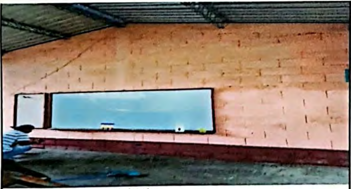
Foto 5: Pintura edificio parte interior
