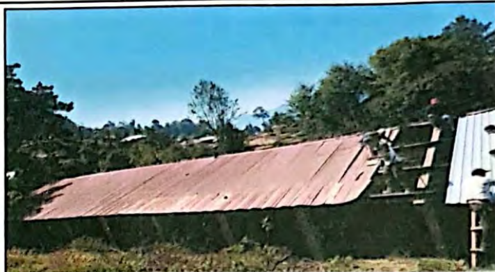
Foto 2: Sustitucion de lamina
