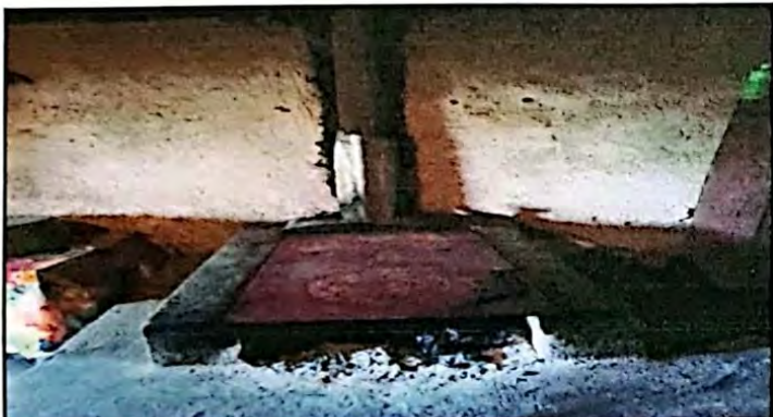
Foto 3: Sustitucion de plancha
