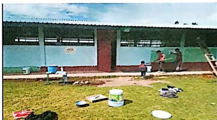
Foto 4: Pintura exterior edificio
