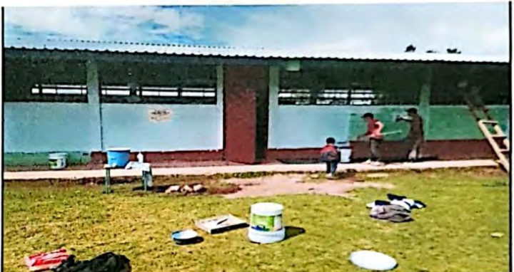
Foto 4: Pintura exterior edificio
