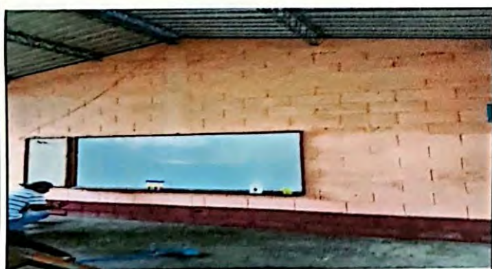
Foto 5: Pintura edificio parte interior
