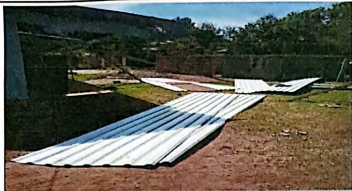
Foto1: Sustitucion de lamina.
