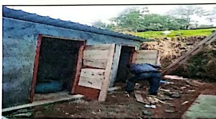
Foto 6: Reparacion de sanitario
