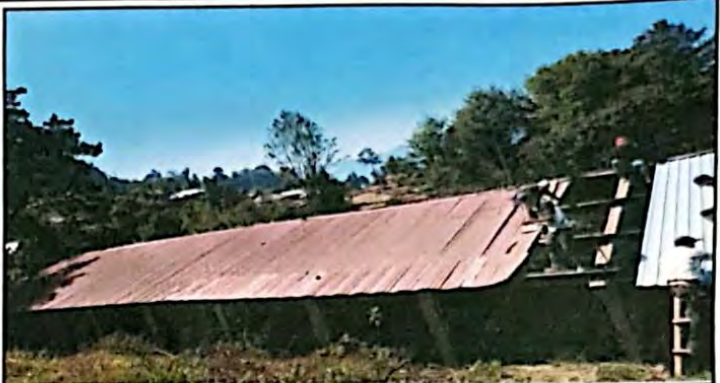
Foto 2: Sustitucion de lamina
