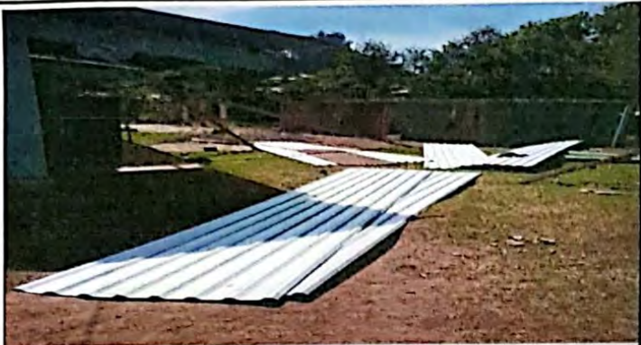
Foto1: Sustitucion de lamina.
