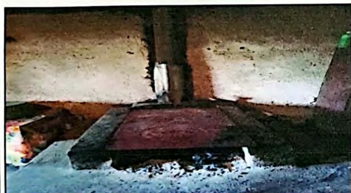
Foto 3: Sustitucion de plancha
